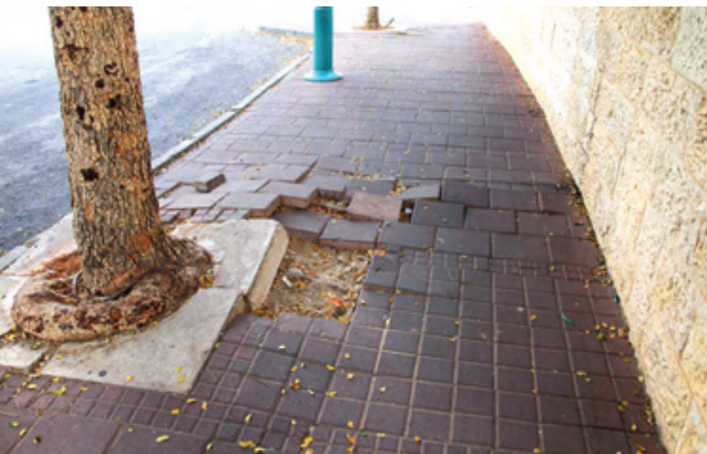
עץ במצוקה עקב נפח קרקע לא מספק בתת הקרקע. תוך ניסיונות הישרדות פוגע העץ בתשתיות וריצופים
