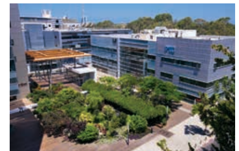
תקרת חניון תת קרקעי - גב ים, הרצליה
