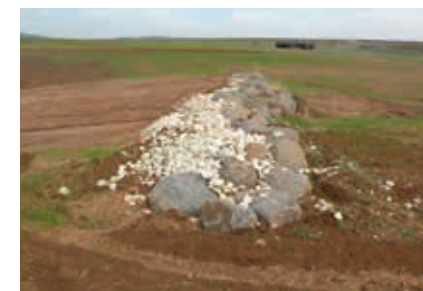
▲ דוגמה לסכרון אבן - מתקן השהיית נגר. מטרת המתקן לגרום להפרעה בנתיב הזרימה ומיתון השיפועים וכך להפחית את קצב הזרימה. יצוין בנוסף השימוש באבנים גדולות וקטנות. האבנים הקטנות שוברות את אנרגיית המים המגיעים אל המתקן וכך שומרות על המתקן. במעלה המתקן נעצרת קרקע שנסחפה מאיזורים גבוהים יותר
